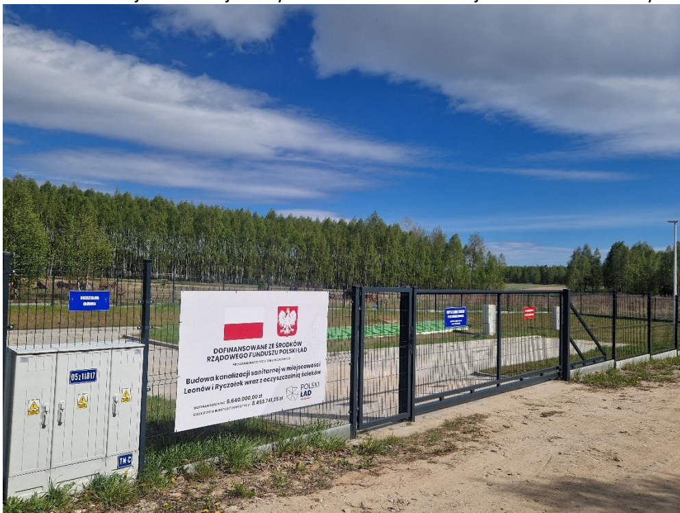
Budowa kanalizacji sanitarnej i oczyszczalni ścieków w miejscowości Leonów i Ryczołek
