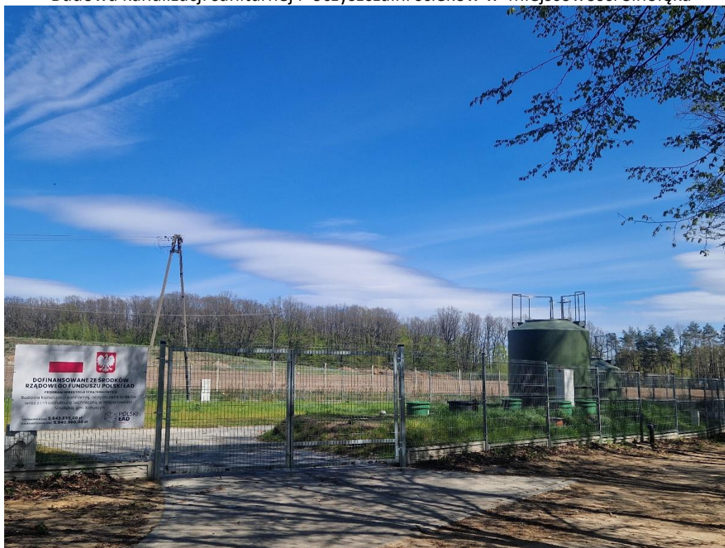
Budowa kanalizacji sanitarnej i oczyszczalni ścieków w miejscowości Sinołęka
