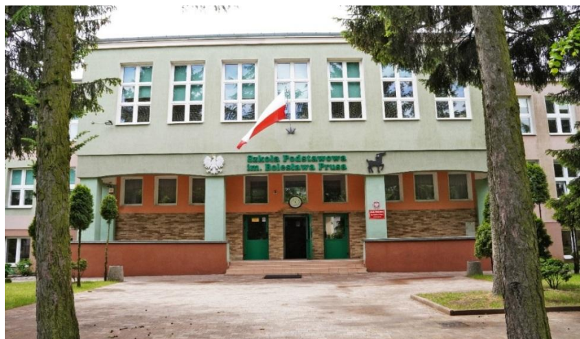
Wejście główne do Szkoły Podstawowej w Kałuszynie od ul. Pocztowej
