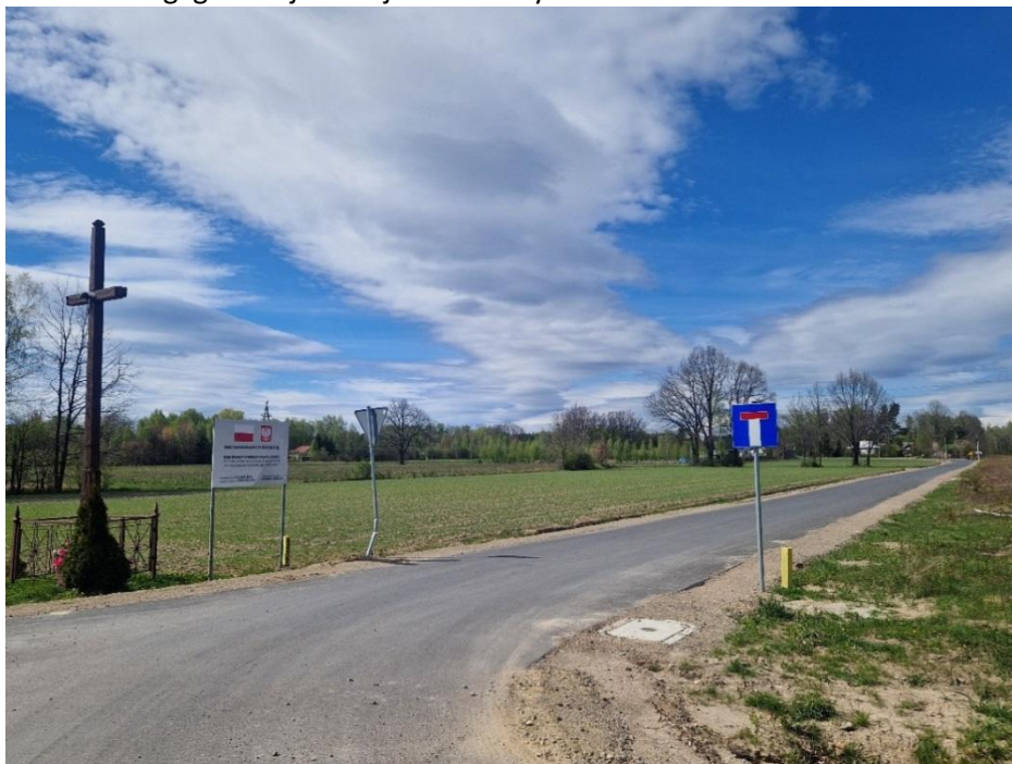
Budowa drogi gminnej w miejscowości Ryczówek
