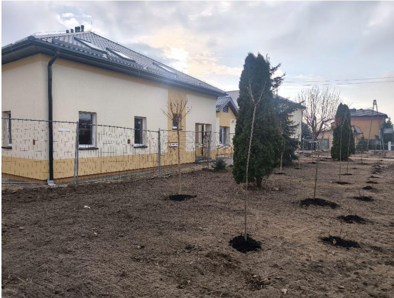
Rozbudowa budynku Domu Kultury
